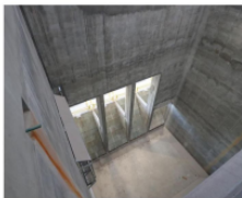
Les déchets seront déposés par les camions dans cette salle - appelée - de base de 2500 m².
