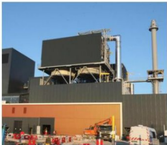
L'incinérateur chapelain est situé derrière le parc des Prés-de-Lyon.
