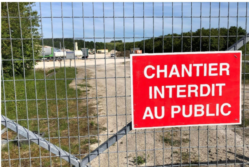
Depuis plusieurs semaines, les engins de la société Trabet ont investi ce terrain jouxtant l'autoroute pour préparer ce chantier évalué à 17 millions d'euros.
